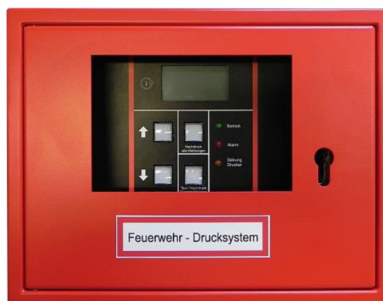
Abbildung 91 Feuerwehr-Drucksystem im Gehäuse
